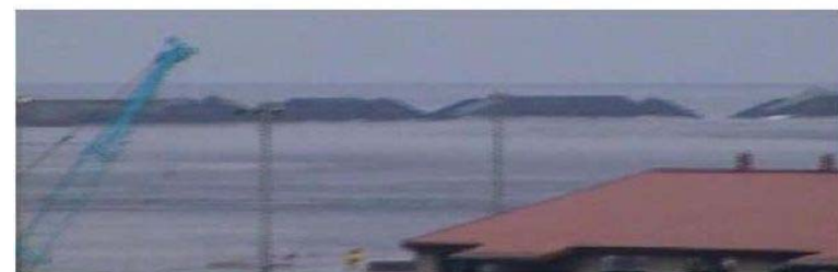
地震発生46分後：津波第1波が引き一部欠けた北堤
