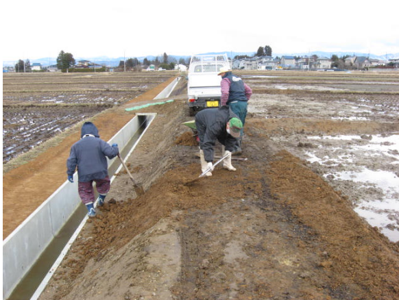
【構成員による施工状況】
