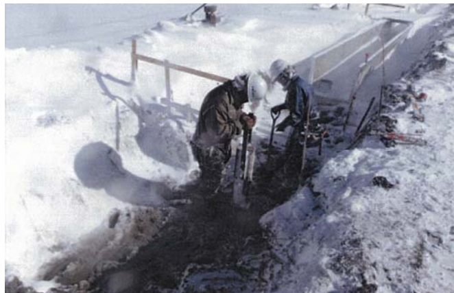
【請負工事の施工状況】
