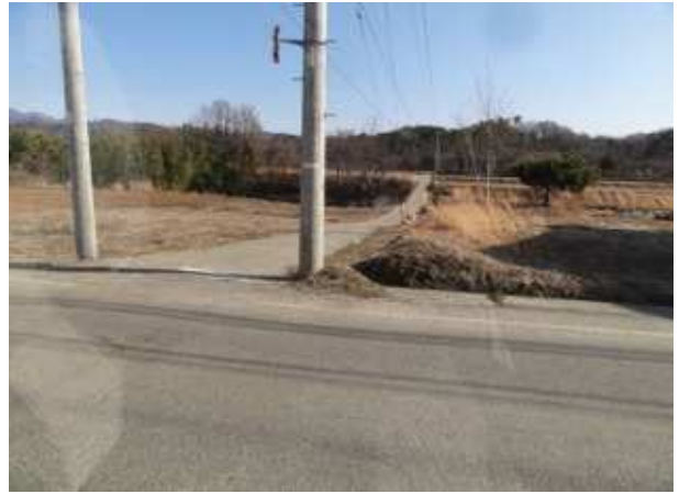
資材供給事業により整備した道路
