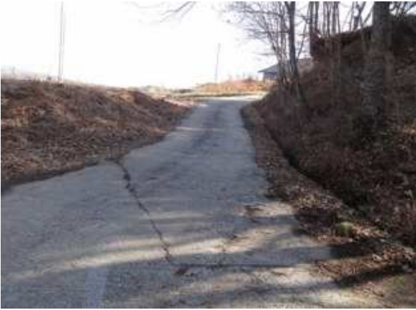
資材供給事業により整備した道路
