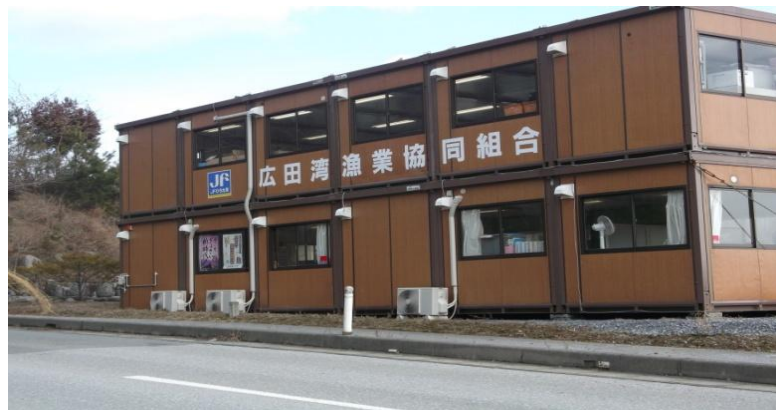
広田湾漁業協同組合仮設事務所 (平成24年3月)
