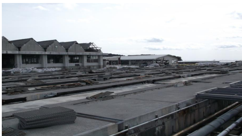
水槽が流失し土台だけが残るアワビ種苗生産施設 岩手県栽培漁業協会 大船渡市末崎町 (平成24年3月)
