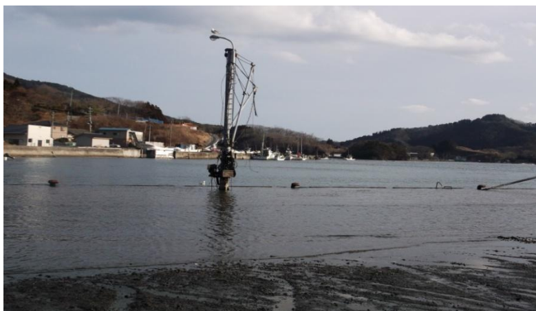
カキ等荷揚施設を備えた大船渡市中赤崎漁港（平成24年3月）
