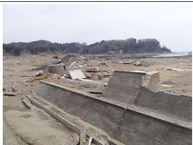
○宮古市田老（破壊された防潮堤防）
