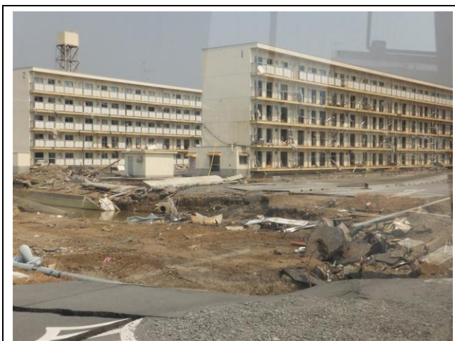
○雇用促進住宅 目視では4階まで浸水
