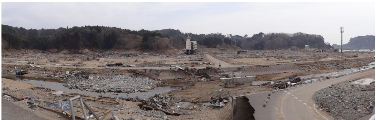
○宮古市田老（防潮堤防から野原地区を望む）
