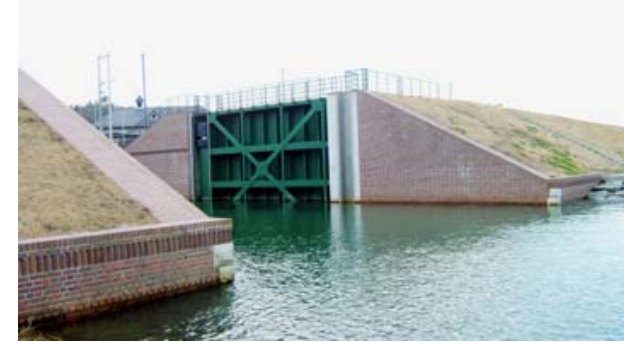
写真. 鳴瀬川、野蒜水門
