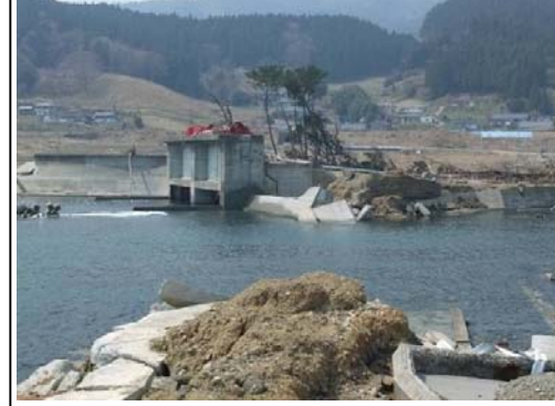
津波の越流により水門上屋が流失
