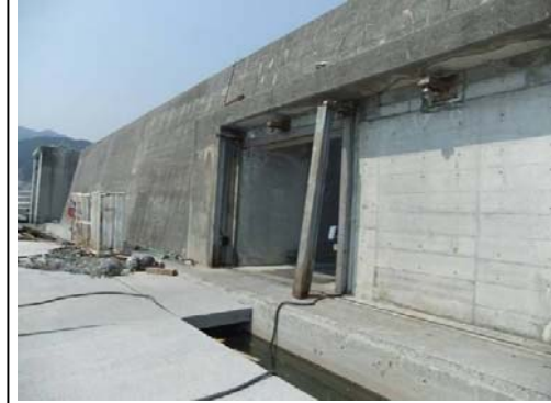
防潮堤比回区間(裏法被覆工なし: 上部工・本体)
