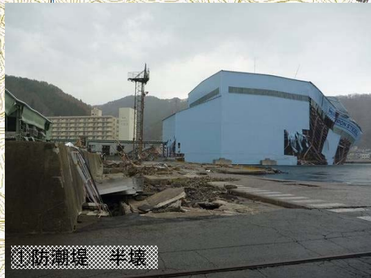
②鉄筋コンクリート造の建物が残存
