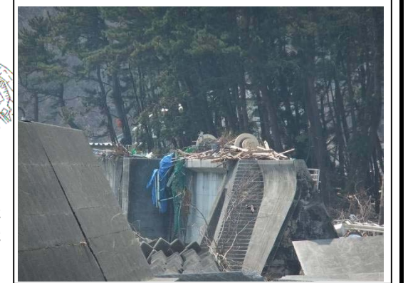
引き波による土砂流失が原因で倒壊したと考えられる
