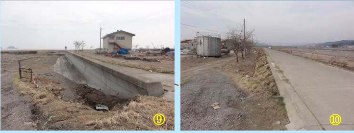
久慈川右岸側は浸水の形跡は見られるが、堤防の表、裏ともに損壊は見られない。(写真⑨～⑩)
