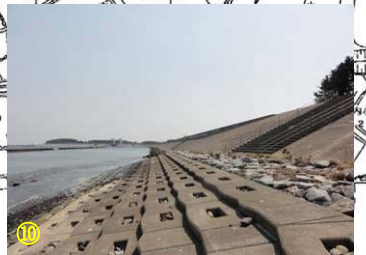
防潮堤の表・裏のり、前面の根固工ともに破損は見られない（写真⑦～⑪）。
