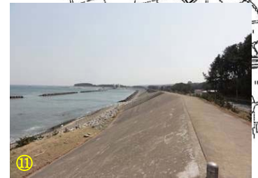
防潮堤の表・裏のり、前面の根固工ともに破損は見られない（写真⑦～⑪）。
