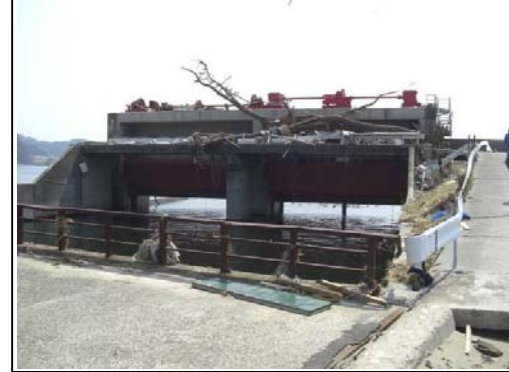
津波の越流により水門上屋が流失
