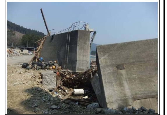
引き波により陸側の扉体が流失し、水流の集中により防潮堤が洗掘被災したと考えられる。
