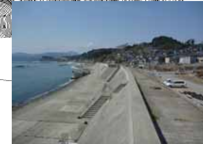
・防潮堤は、表のり、裏のりとも大きな損傷はない。裏のりは護岸の植生土のうが流出している。 ・1号水門は、大きな損傷は確認されないが、2号水門の上屋は損傷を受けており、機械設備等も被害を受けていると思われる。 ・背後地の家屋は、防潮堤沿いは流出しているが、丘地形であり防潮堤と同標高程度より高い箇所では被害は無い。
