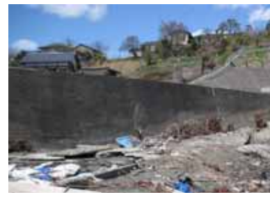
防潮堤の大部分は健全な状態を保持している
