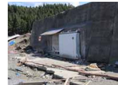
陸閘は健全な状態にある。
