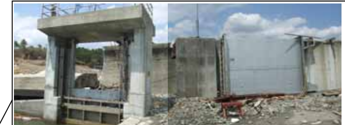
水門、陸閘、防潮堤の残存(約65m)
