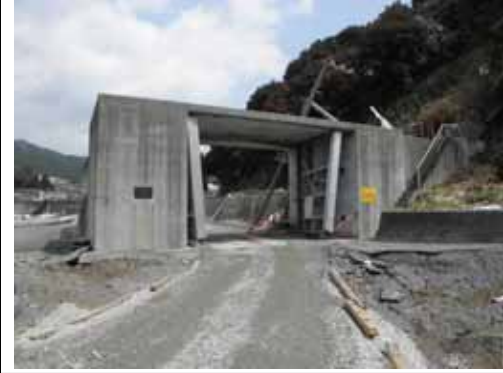
引き波により陸閘の扉体損傷
