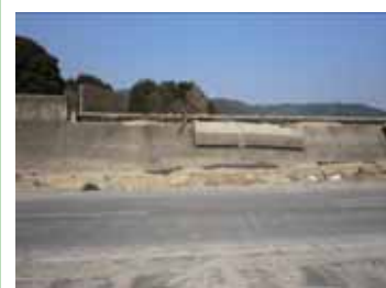
引き波により上部工一部損壊
