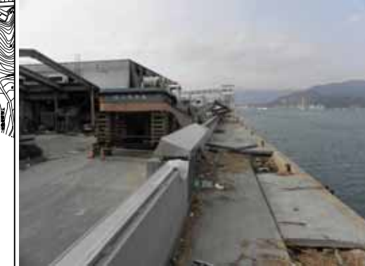
引き波により防潮堤前面の洗掘
