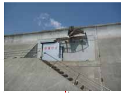
通路2号門扉はゲートが流出、3号門扉のカバーが破損している。
