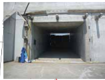
通路2号門扉はゲートが流出、3号門扉のカバーが破損している。
