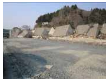
引き波により上部工一部損壊
