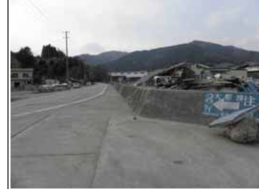
防潮堤に大きな変状は見られない
