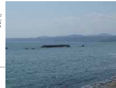
離岸堤の一部が流出している。
