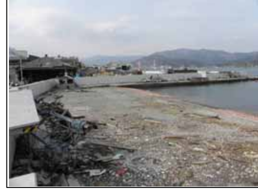
防潮堤背後には洗掘等は見られない
