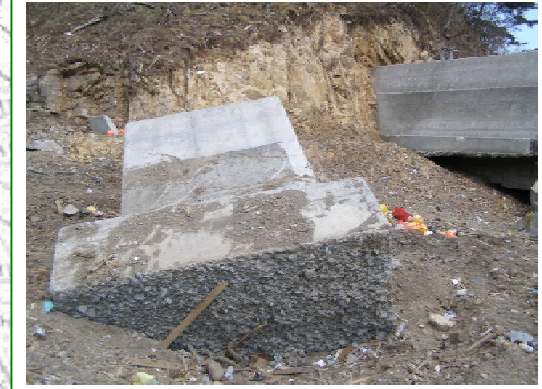
押し波により門柱が倒壊し、陸側20mの位置まで流出。
