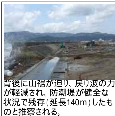
防潮堤の健全区間(約140m)
