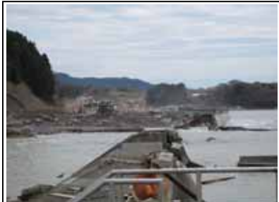
防潮堤の破堤(約250m)
