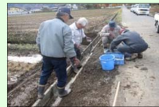
水路の補修 (施設の長寿命化)
