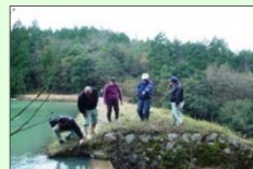
ため池の点検 (日常の管理)
