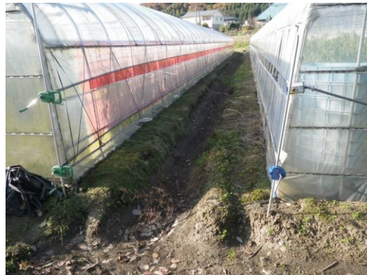
写真5 ハウス周囲の排水溝の設置例
