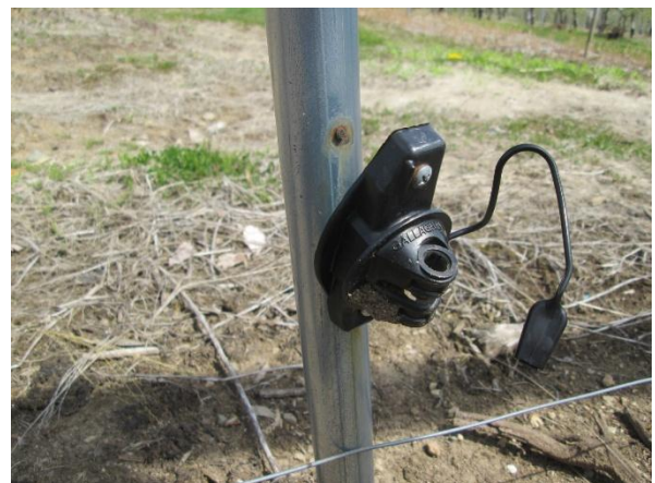
写真3 雪にワイヤーが引っ張られて破損した碇子
