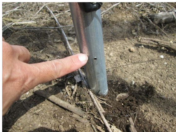
写真4 単管パイプ下部に設置した水抜き穴
