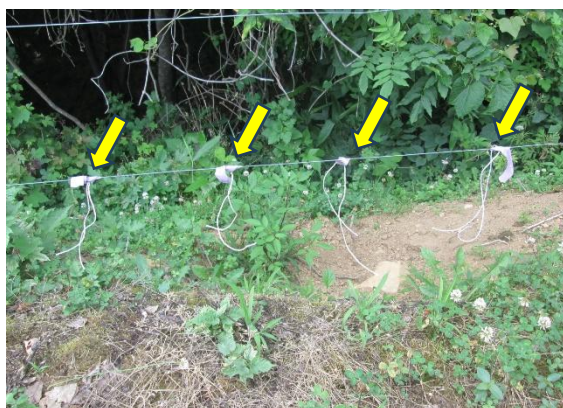
写真5 ポリワイヤー（左）とフェンシングワイヤー（右）を使った凹凸への対応
