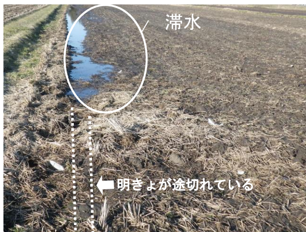
写真4 明きょがしっかり施工されず滞水した様子
