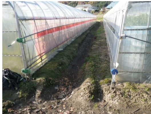
写真5 ハウス周囲の排水溝の設置例
