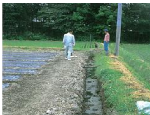
写真6 水田転換畑の明きよの設置例
