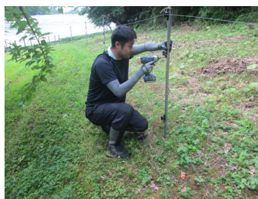
高さを調整しクマ・シカ兼用の柵に改修 （5段：20、40、70、100、130 cm）
