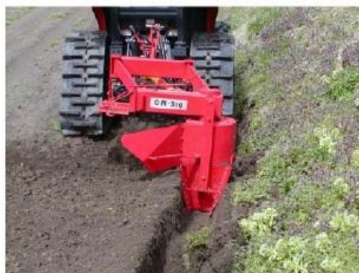
写真3 排水溝（額縁明渠）の設置
