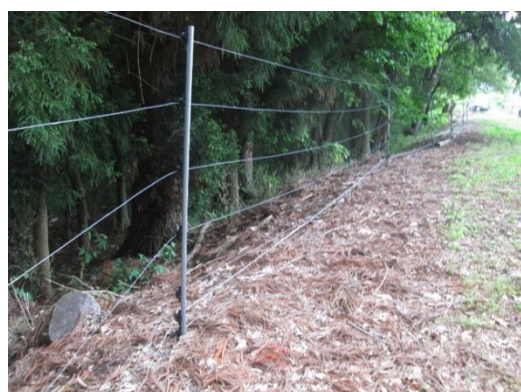
シカ対策で導入した電気柵 （5段：30、60、90、120、150 cm）
