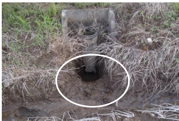
写真4 排水口の掘り下げ
