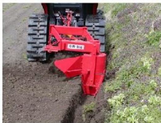
写真3 排水溝（額縁明渠）の設置
