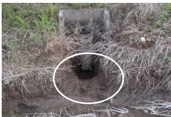
写真4 排水口の掘り下げ
