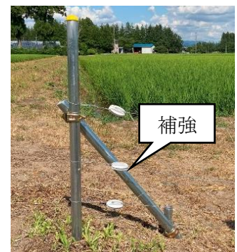
写真7 角支柱の補強
