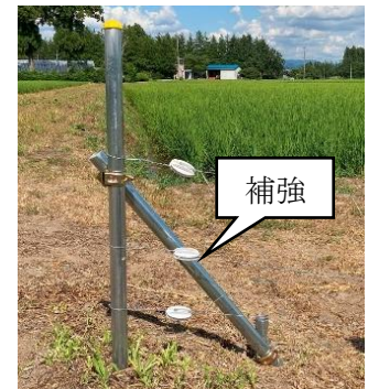
写真7 角支柱の補強
