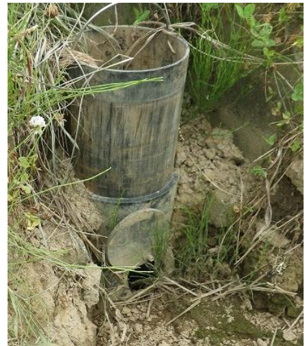
写真6 排水口まで掘り下げ明渠と接続する
