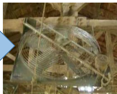
図7 換気扇掃除の効果（左：掃除前 右：掃除後（換気扇から2kgのホコリを除去）
