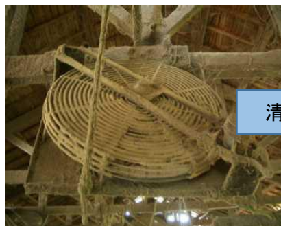
図7 換気扇掃除の効果（左：掃除前 右：掃除後（換気扇から2kgのホコリを除去）
