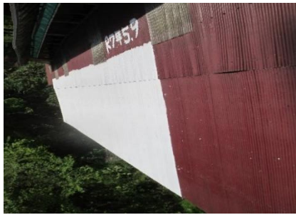
波板トタンの屋根に遮熱塗料を塗布
