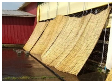
外側の壁に「よしず」を設置
