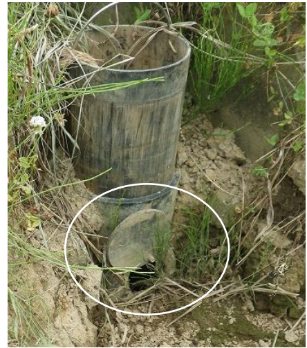
写真1 排水口まで掘り下げ
