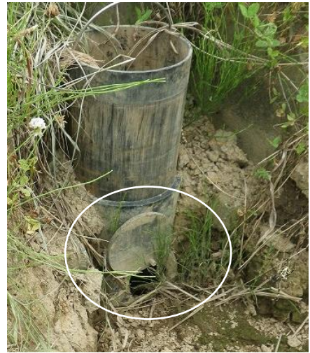
写真1 排水口まで掘り下げ
