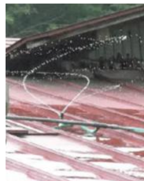
写真 14【気化熱】 屋根への散水
