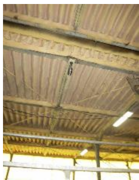
写真 12【断熱】 屋根裏へのウレタン吹き付け
