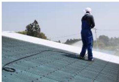
写真 13【遮熱】 牛舎屋根表への石灰塗布
