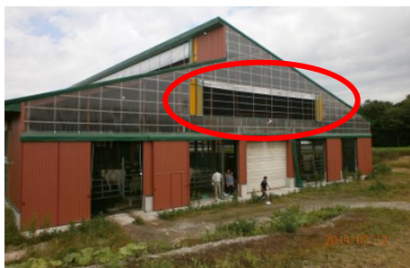
写真 15 妻面を開放（順送換気）
