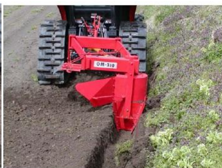
写真3 溝堀機による明渠の設置
