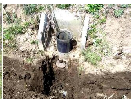
写真4 排水口への接続
