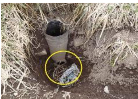
写真3 明渠からの排水が確実にほ場の外へ流れるよう、排水口を掘り下げます。ゴミなどが溜まっていると、スムーズに排水できなくなりますので、点検し、取り除きます。
