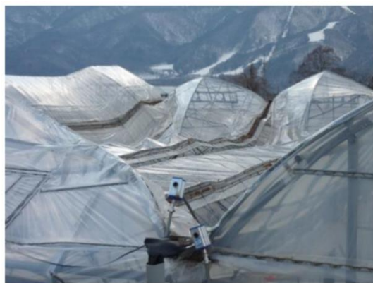
連棟パイプハウスの倒壊
