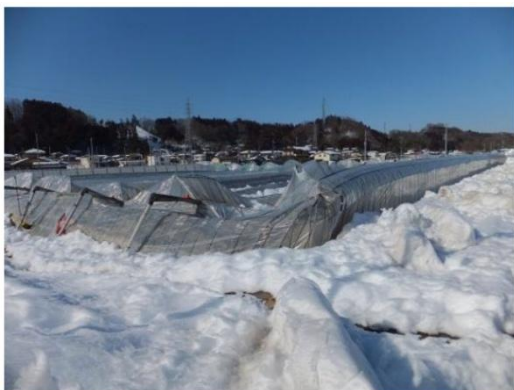
連棟パイプハウスの倒壊
