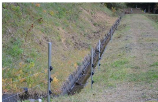
写真 恒久電気柵の設置例
