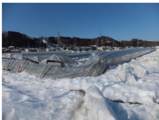
連棟パイプハウスの倒壊
