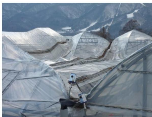
連棟パイプハウスの倒壊
