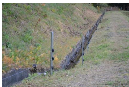
写真2 恒久電気柵の設置事例
