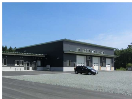
米穀乾燥調製施設（H30～R1 整備） （収量コンバイン等の D X 化に対応）
