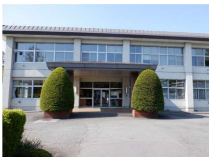
管理棟（S55 整備） （保健室のみエアコン設置済み）
