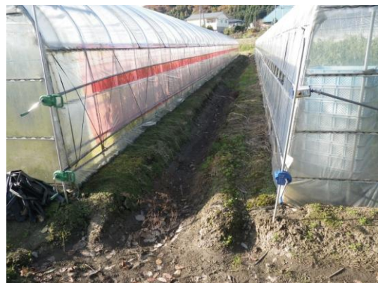
ハウス周囲の排水溝設置事例
