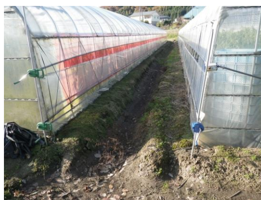
ハウス周囲の排水溝設置事例
