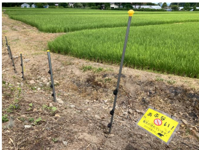
写真 4 河川と農地の間に設置された恒久電気柵
