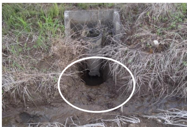
写真5 排水口の掘り下げ 水尻は大きく掘り下げ、排水溝とつなげ、フリードレン下部から排水。
