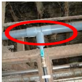
配管を太くすることで一度に十分な水量を供給できます
