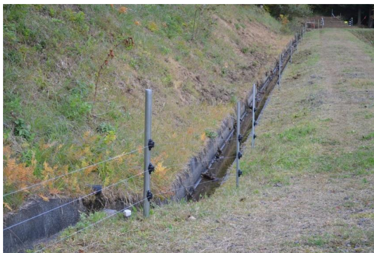
写真 1 恒久電気柵の設置事例（一関市）
