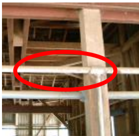
配管を太くすることで一度に十分な水量を供給できます
