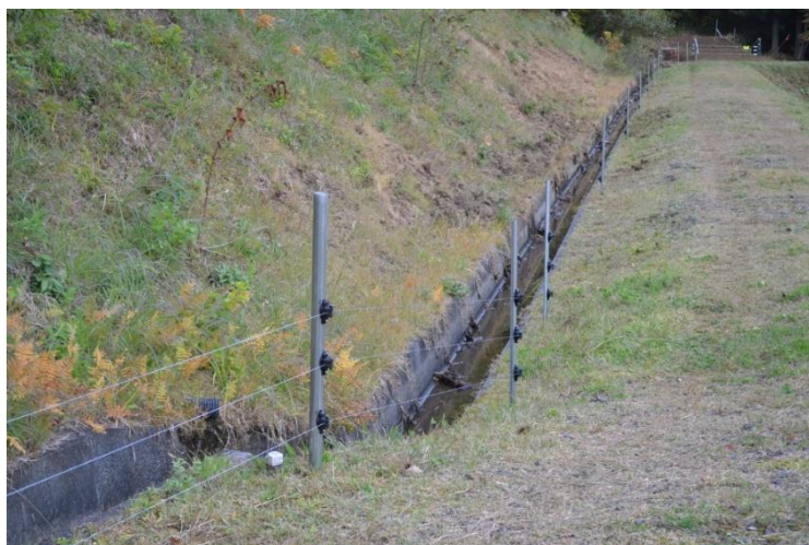
写真 1 恒久電気柵の設置事例（一関市）
