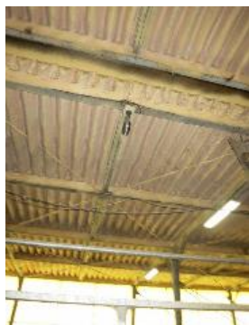
【断熱】屋根裏へのウレタン吹き付け
