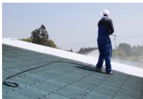
【遮熱】牛舎屋根表への石灰塗布
