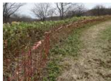
ワイヤーメッシュ立体柵 (溶接金網を高さ1m、奥行1m の箱型にして設置)
