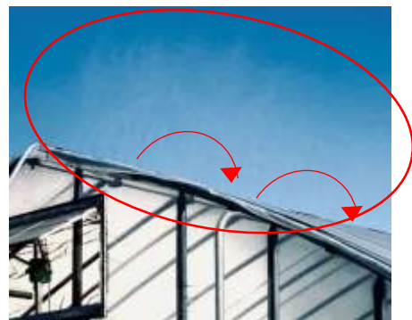
灌水チューブから屋根面に散水 している様子
