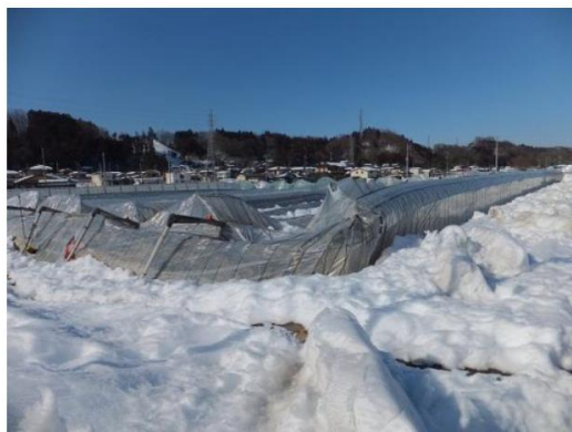
連棟パイプハウスの倒壊
