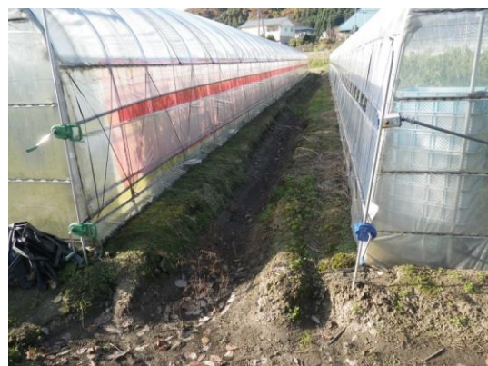
ハウス周囲の排水溝設置事例
