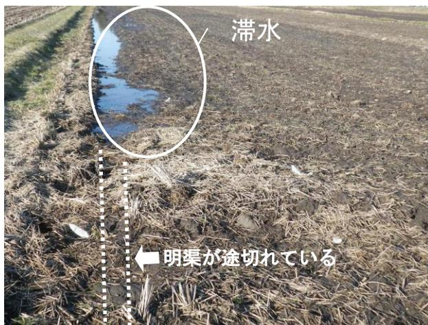
写真1 明渠がしっかり施工されず滞水した様子
