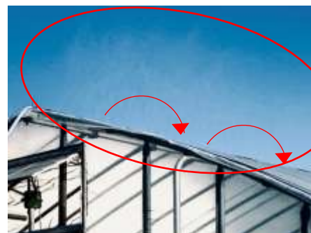
灌水チューブから屋根面に散水している様子
