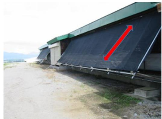
写真2 軒下へ寒冷紗を設置し西日を遮断
