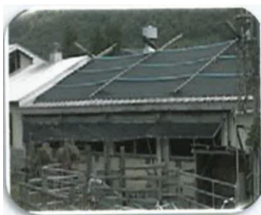
写真1 屋根表面への寒冷紗の設置 ※屋根と寒冷紗の間に角材等ですき間を設けると断熱効果上がる
