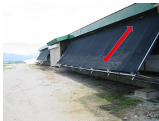
写真2 軒下へ寒冷紗を設置し西日を遮断 ※ハウスの「くるくる」を用いて巻き上げ巻き下げができる事例
