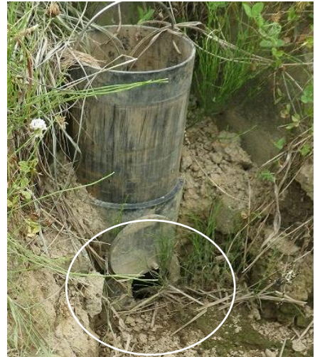
写真1 排水口まで掘り下げ
