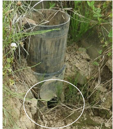
写真1 排水口まで掘り下げ
