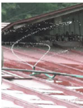
写真 17 屋根表への散水
