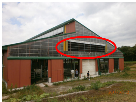
写真 19 妻面を開放（順送換気）
