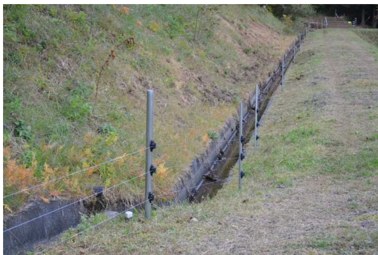
写真 1 恒久電気柵の設置事例（一関市）
