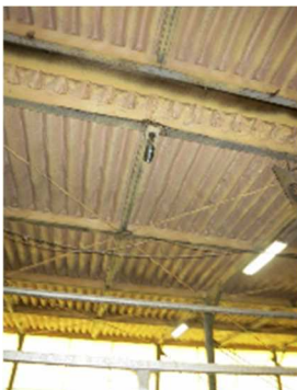
【断熱】屋根裏へのウレタン吹き付け
