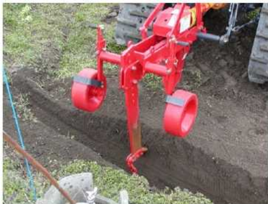
写真2 弾丸付サブソイラでの施工
