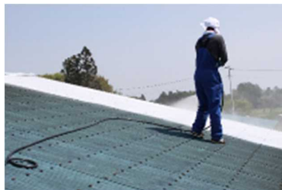
【遮熱】牛舎屋根表への石灰塗布
