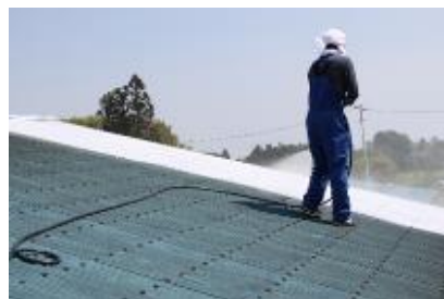
【遮熱】牛舎屋根表への石灰塗布
