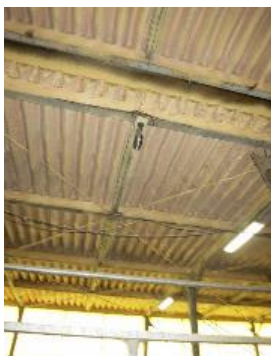
【断熱】屋根裏へのウレタン吹き付け
