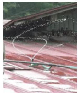
【気化熱】屋根への散水
