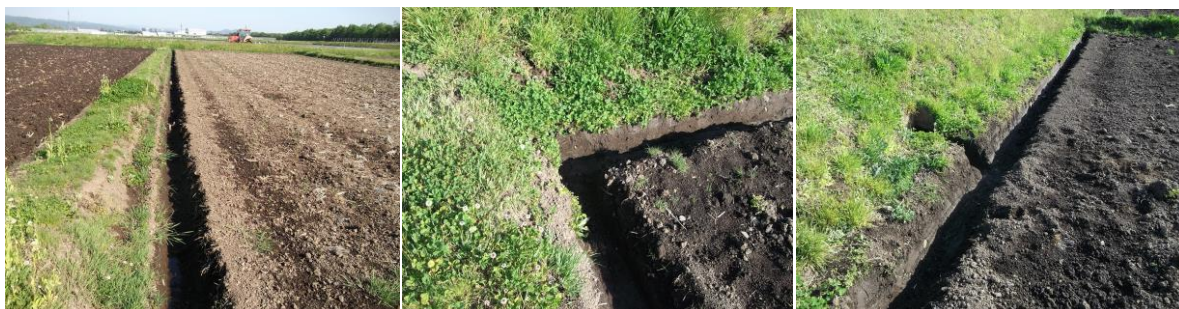
りんどう定植予定圃場の周囲に掘られた明渠（必ず排水口につなげること）
