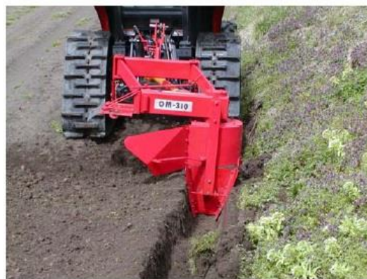
写真3 溝堀機による明渠の設置
